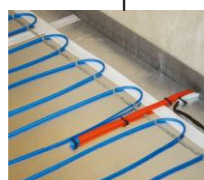
Topná rohož v koupelně Čidlo teploty v podlaze
