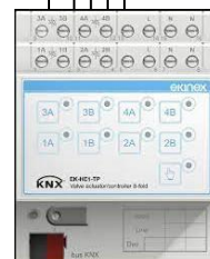
EK-HE1-TP KNX řízení termopohonů v RB
