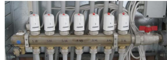
rozdělovač podlahového topení
